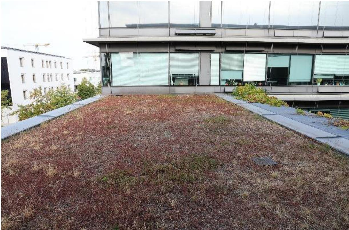
*Trockenstress bei einer extensiven Dachbegrünung, sichtbar durch Rotfärbung des Sedums.*
