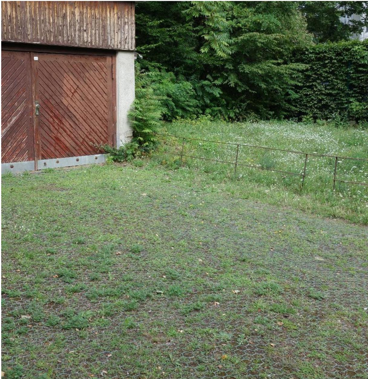
*Begrünte Beläge als Garagenausfahrt in Berlin Mitte neben einer Vegetationsfläche. Das Fugensubstrat des Rasengitters ist extrem verdichtet. Als Folge entwickelt sich nur eine spärliche Vegetationsdecke und Niederschläge fließen vermehrt oberflächlich ab.*
