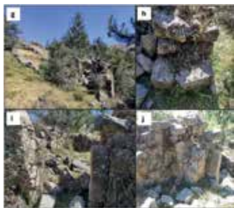
Figura 7. (g) Detalles del primer vano de acceso al interior del molino hidráulico; (h) sección de un muro de la estructura del molino; (i) segundo vano de acceso al ambiente de molienda y (j) muro del ambiente contiguo al área de molienda. Fuente: Fotografías del autor.
