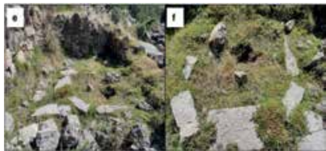
Figura 6. Imágenes del interior del segundo nivel del molino hidráulico (e; f). Fuente: Fotografías del autor.
