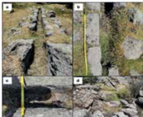
Figura 5. Imágenes del canal de piedra tallada que conducía el agua que accionaba el molino hidráulico (a; b; c; d). Fuente: Fotografías del autor.
