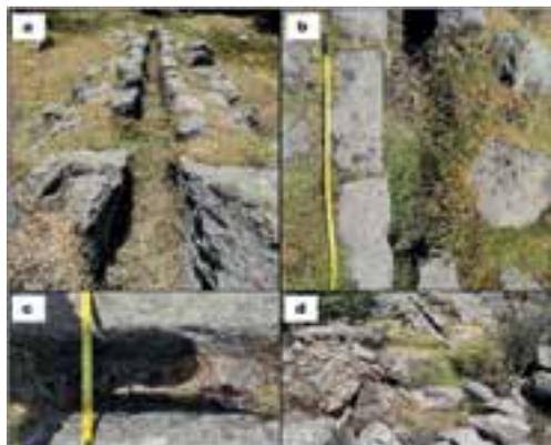
**Figura 5.** Imágenes del canal de piedra tallada que conducía el agua que accionaba el molino hidráulico (a; b; c; d).
