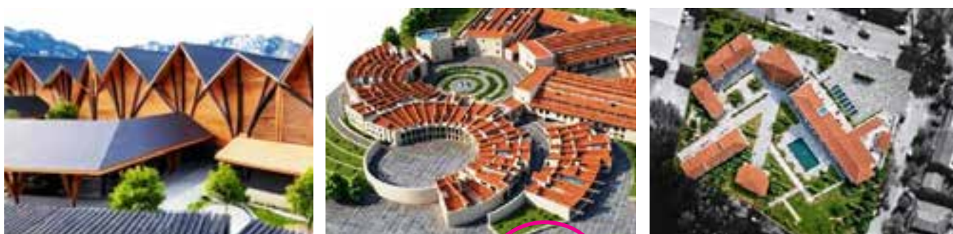
Figura 8. (izquierda: Centro de acopio, Centro: Centro del adulto mayor; derecha: ?)
