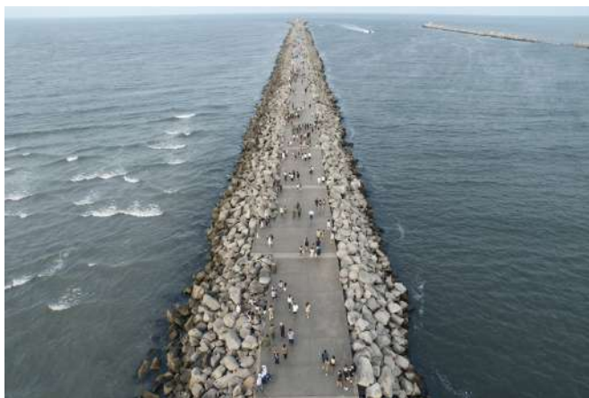
Figura 2. Escolleras lado norte y sur en Golfo de México
