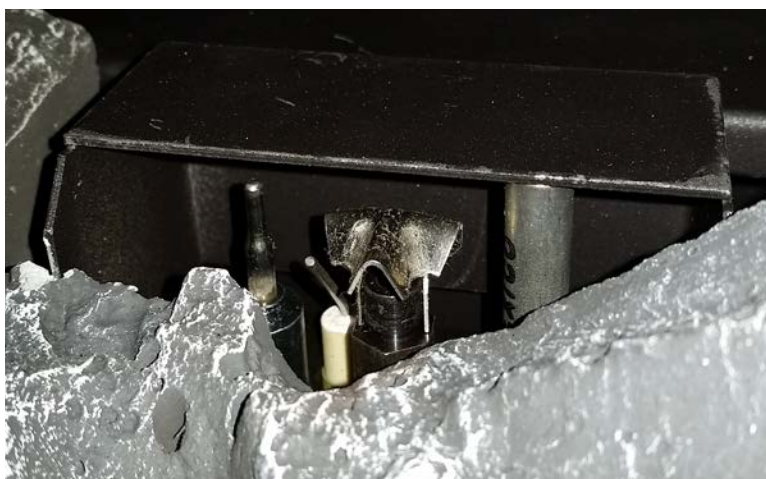
Figure 18. Ensemble de la veilleuse à côté du brûleur.
