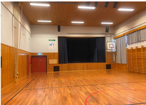
Bilde 3. Innvendige overflater i gymsal.
