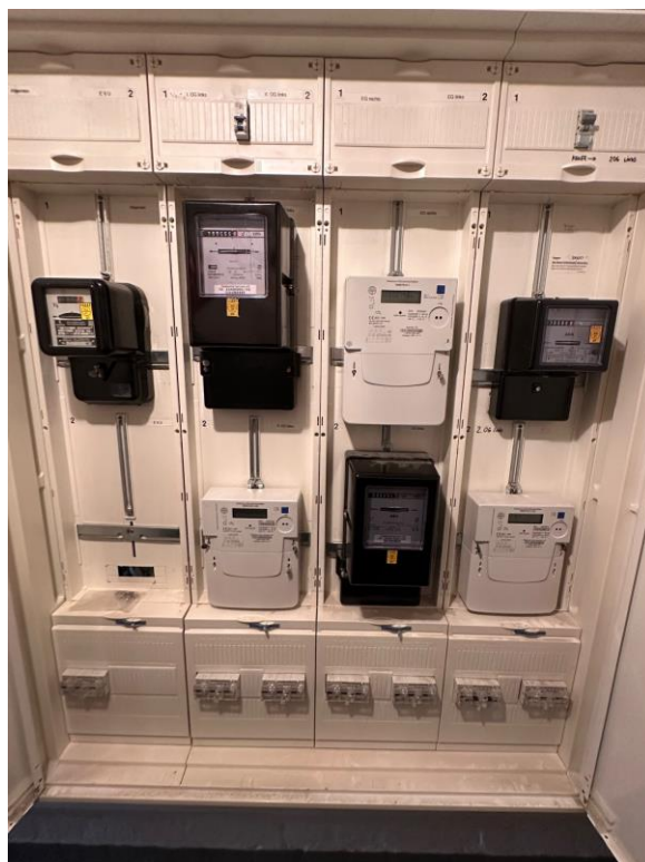
Elektroschaltkasten Hausanschluss
