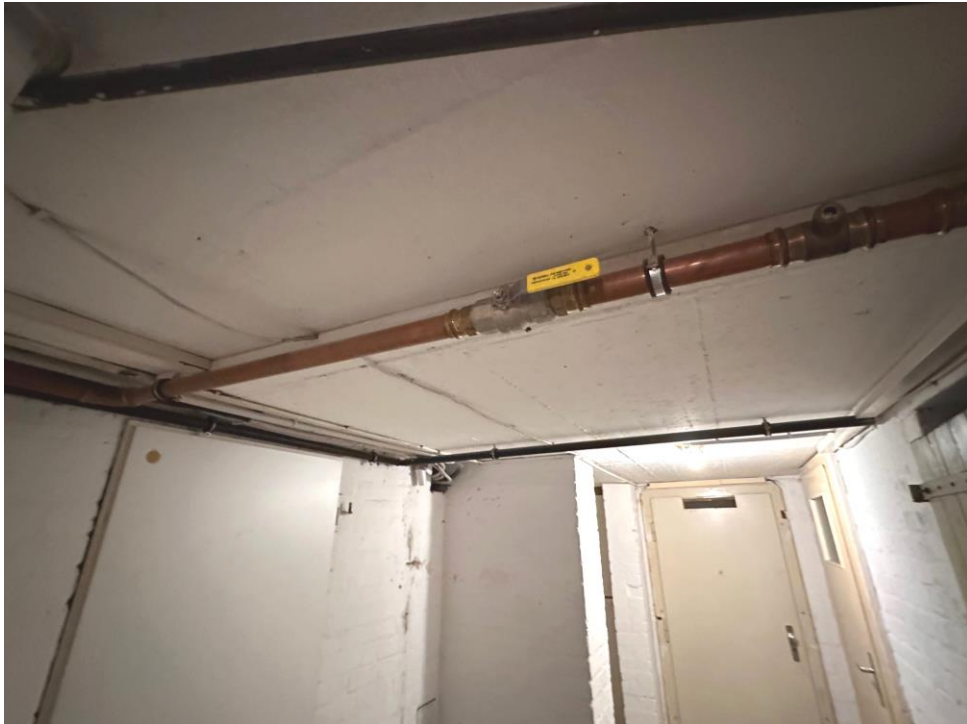
Neue Steig-, Fall- und Gasleitung
