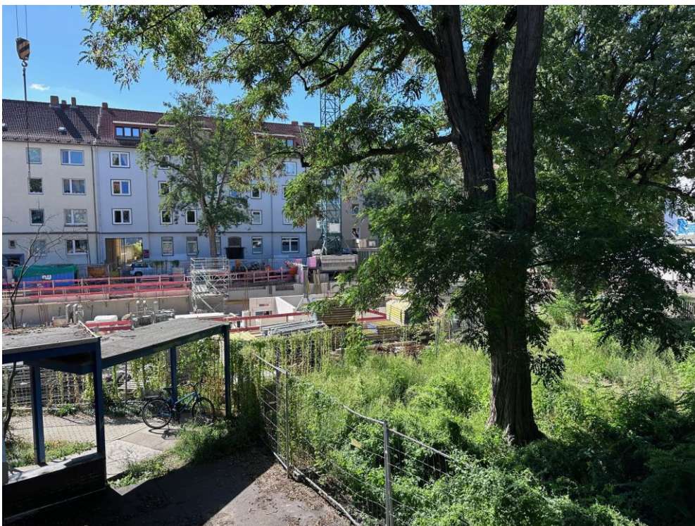
Ausblick zur Baustelle
