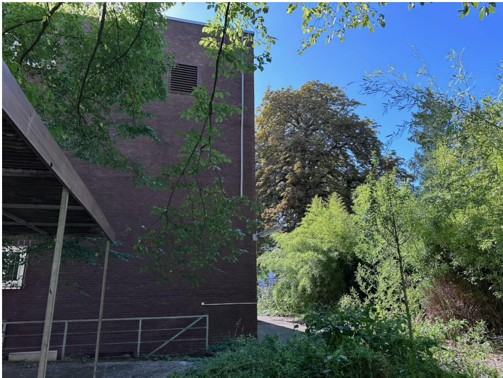
Rückansicht mit Freifläche und Fahrradunterstellplatz
