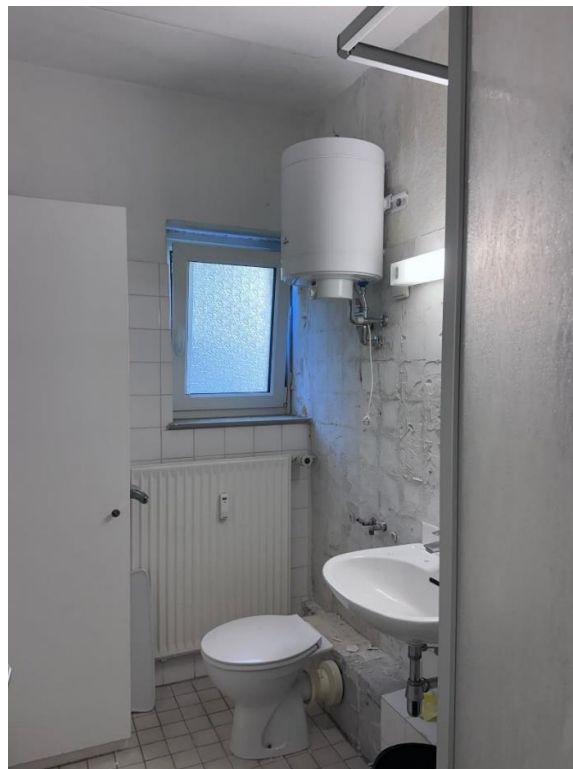
Hinterer WC – Bereich 02
