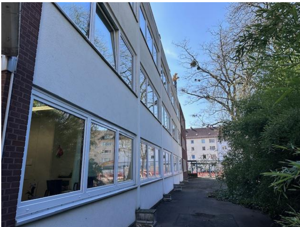
Seitenansicht zur Dieterichsstraße
