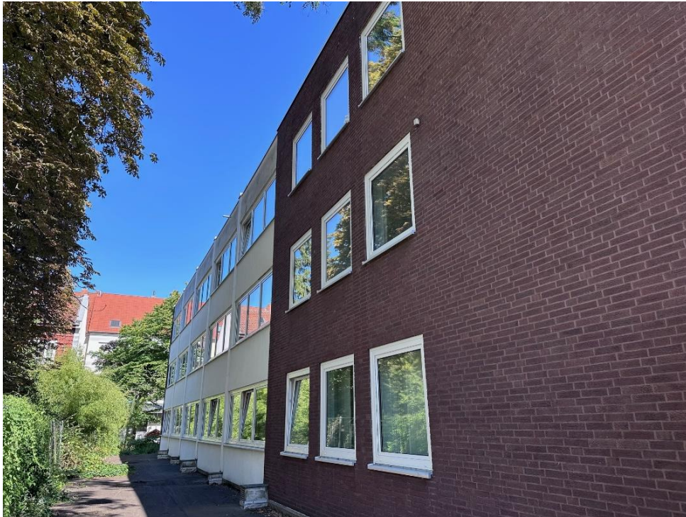
Seitenansicht zur rückwärtigen Freifläche
