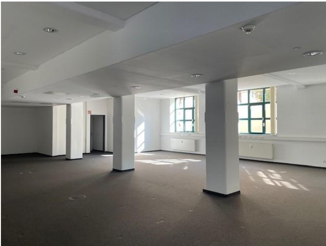
Büro im Teil zur anderen Seite der Fläche, vor Renovierung/Umbau
