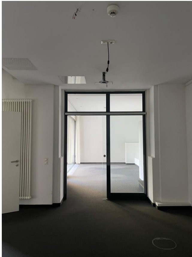
Durchgang innen zum Meetingpoint / Besprechungsraum
