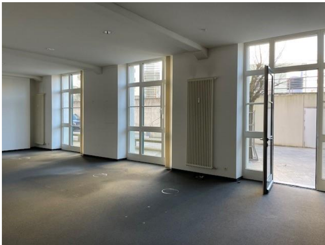
Büro im Teil des Eingangs zur Mietfläche, vor Renovierung/Umbau
