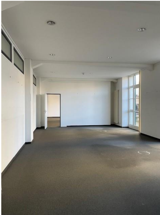
Büro im Teil des Eingangs zur Mietfläche, vor Renovierung/Umbau
