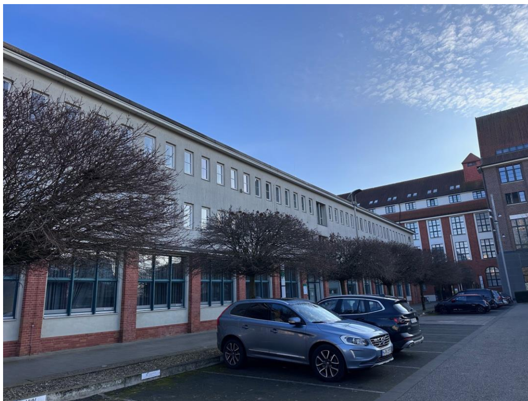
Haus 3, Außenansicht, EG (Praxis ungeeignet)
