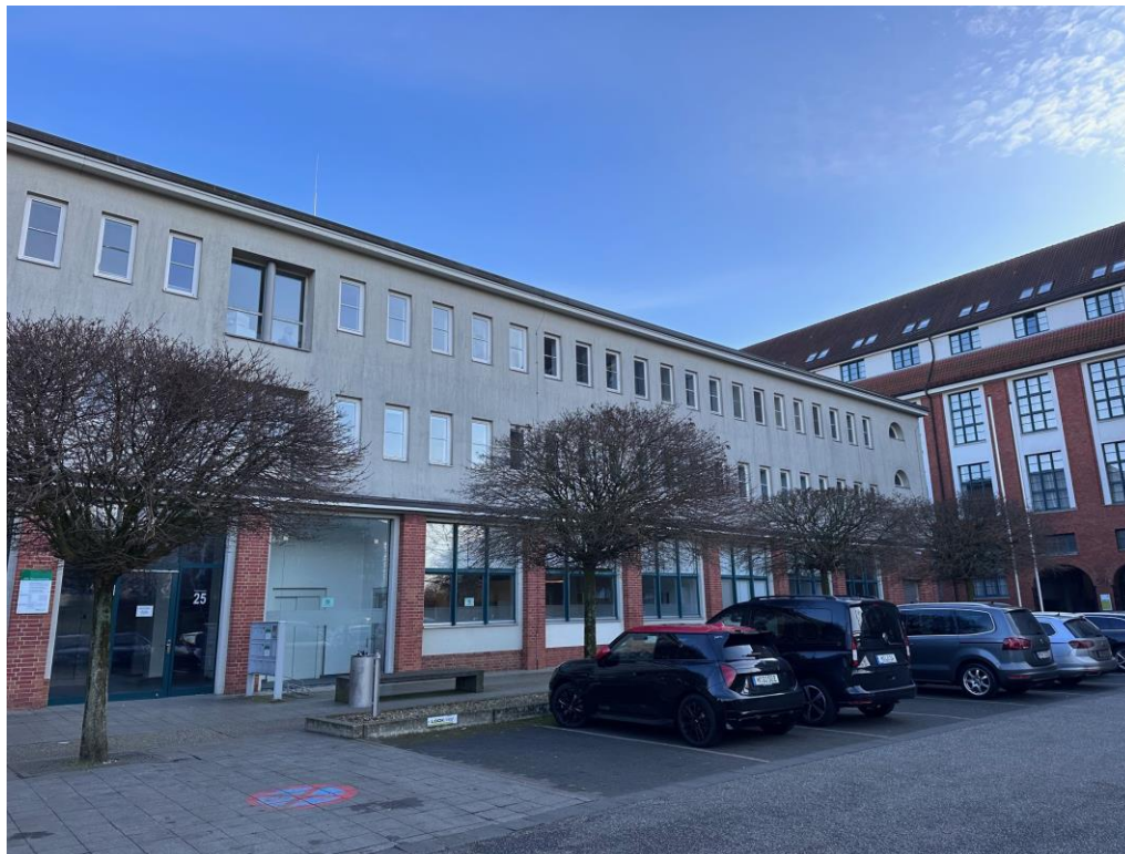
Haus 3, Außenansicht, EG (Praxis ungeeignet)
