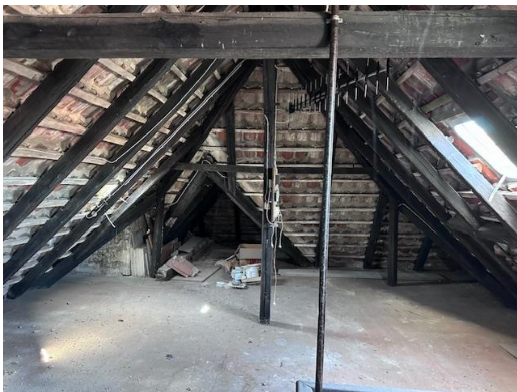
Nicht ausgebauter Spitzboden
