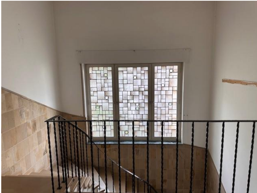
Treppenhaus mit großem Fenster
