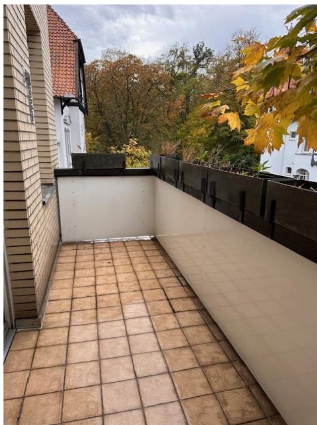
Balkon im 1. Obergeschoss
