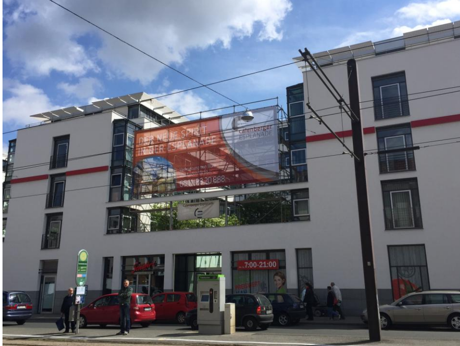
Neue Fassade Humboldtstraße
