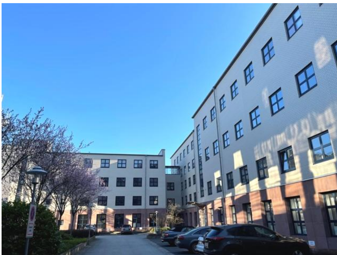
Innenhof mit Parkplätzen
