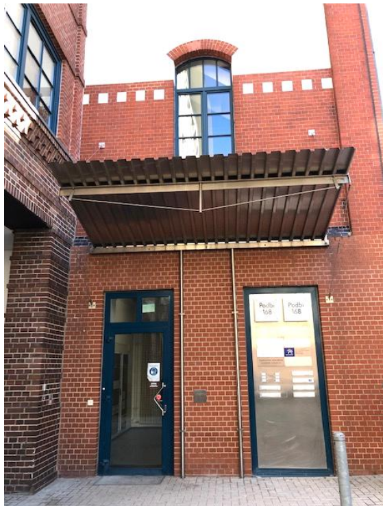
Bürohaus Eingang 168, Mietfläche im 2. OG
