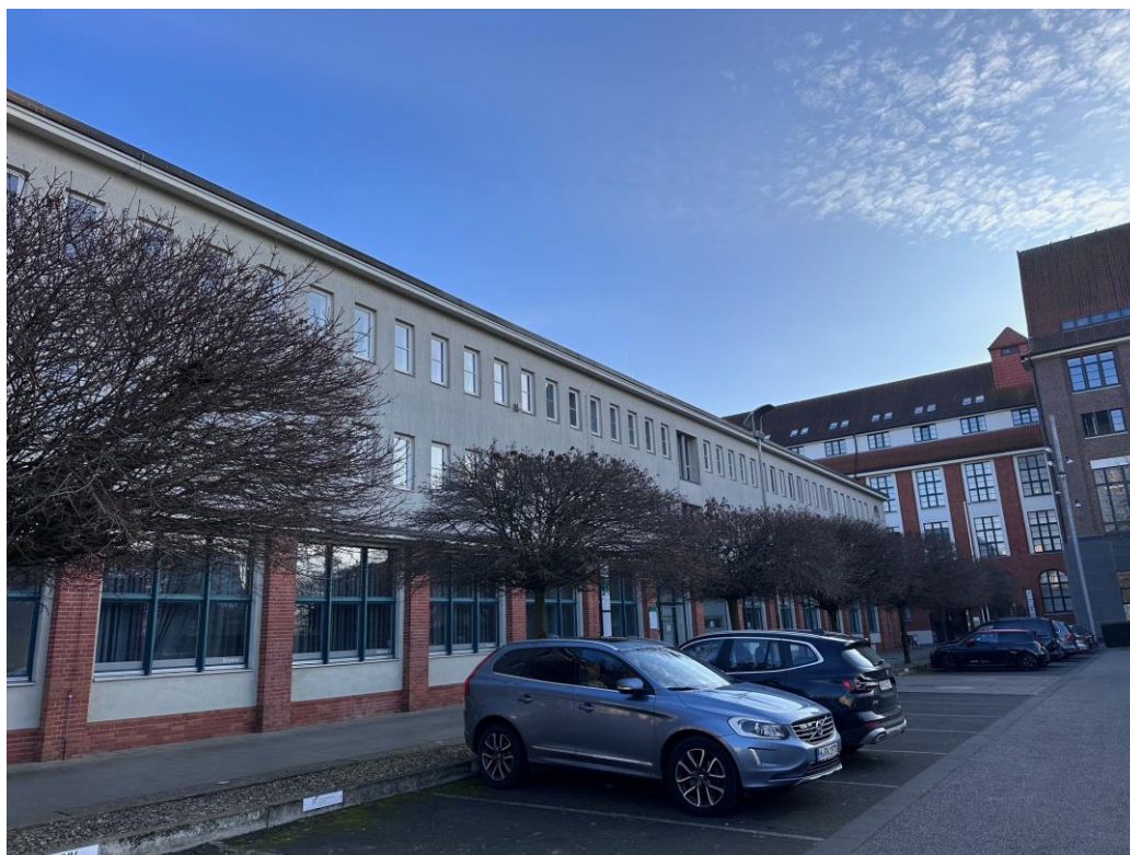
Haus 3, Außenansicht, EG (Praxis ungeeignet)
