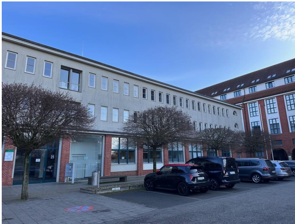
Haus 3, Außenansicht, EG (Praxis ungeeignet)
