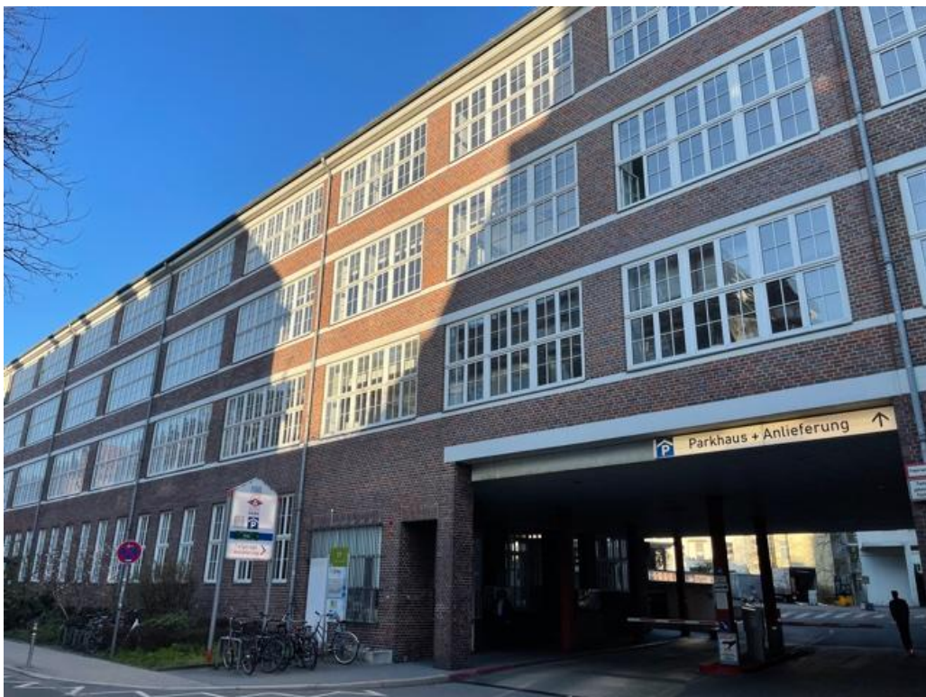
Lister Straße, Einfahrt zur Tiefgarage
