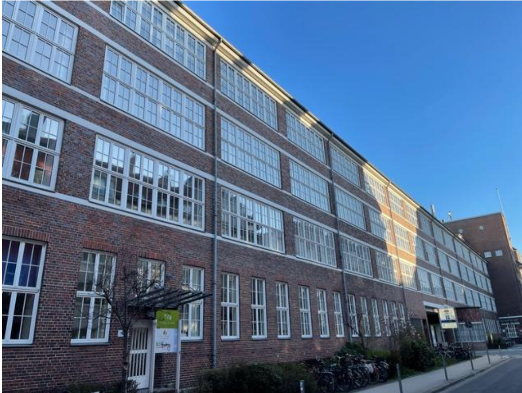
Lister Straße, Blick Richtung Haupteingang
