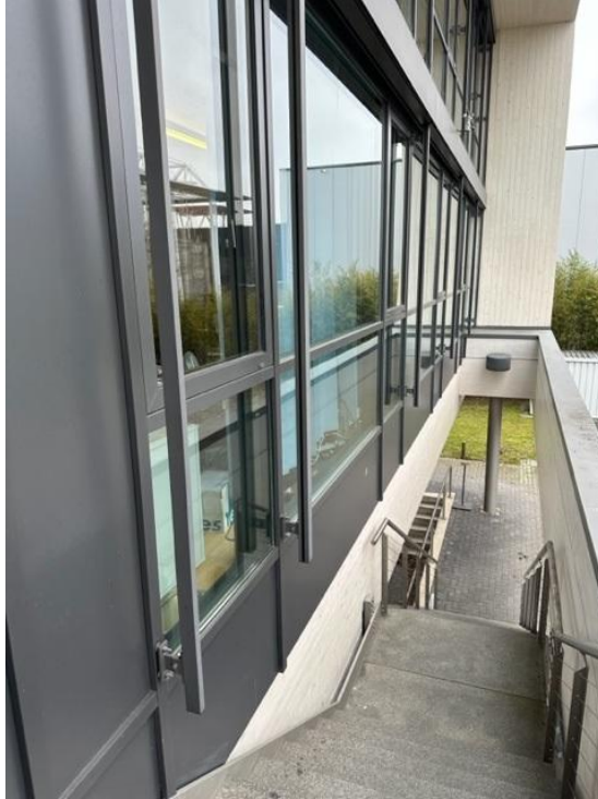
Hinteres Treppenhaus mit Ausgang zu den Stellplätzen
