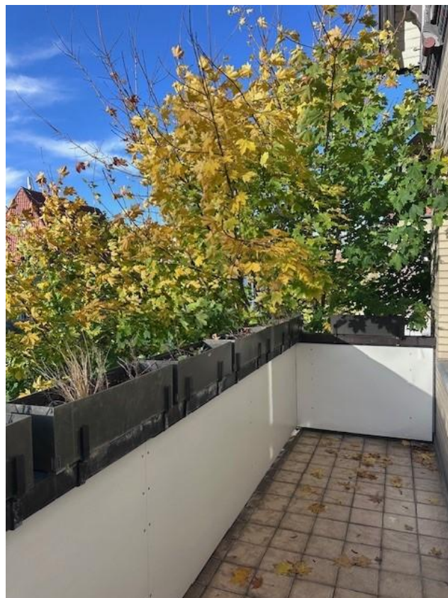
Balkon im 1. Obergeschoss zur Hegelstraße
