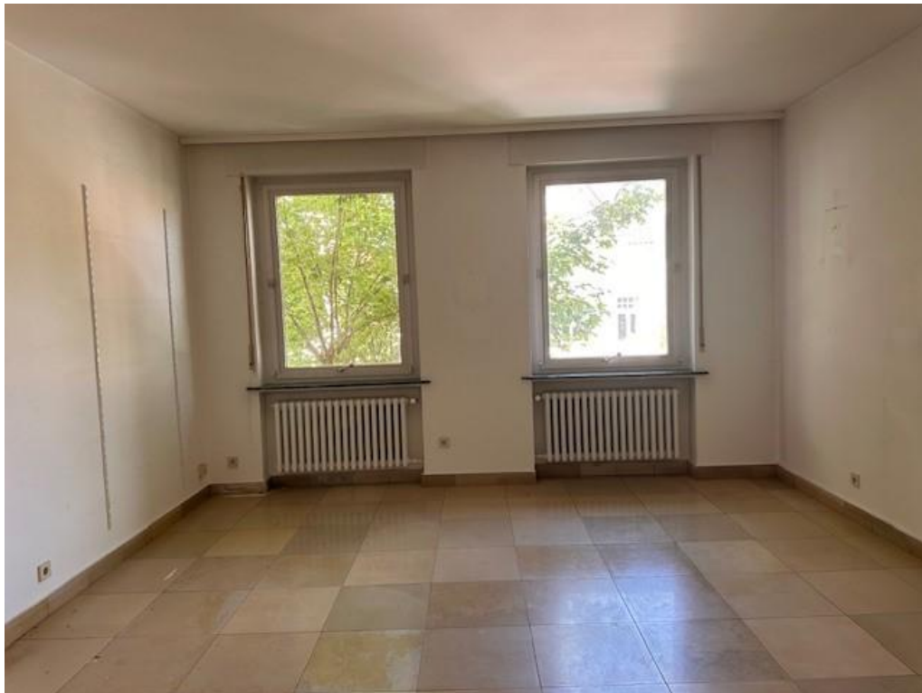
Zimmer 01. zur Hegelstraße im 1.Obergeschoss
