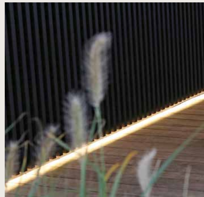
Sfeerled wand Indirecte verlichting onder de vaste wand.
