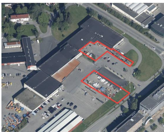
Figur 1 Skråfotoet ovenfor viser arealer utendørs som brukes for varer, oppstilling av maskiner, hagesenter og manøvreringsareal knyttet til varehåndtering og salg.
