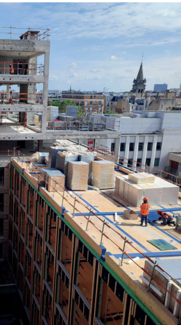
Edificio en fase de construcción.
