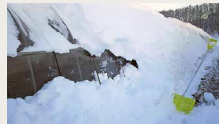
積雪によるハウス被害
