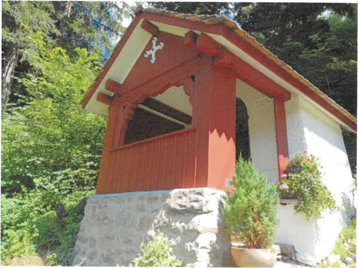
Beigenkapelle nach der Sanierung
