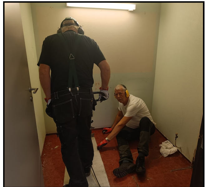
Her Jørn Jansen i full gang med renovering i et av i alt 11 bad som ble renoverert høsten 2025
