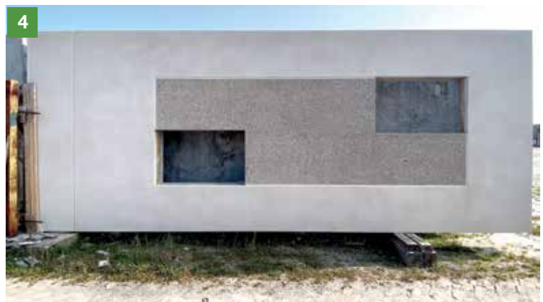
4. An insulated double-wythe precast concrete panel at the plant, ready for shipment to the building site. / Un panneau de béton préfabriqué à double paroi isolé à l'usine, prêt à être acheminé au chantier de construction.
