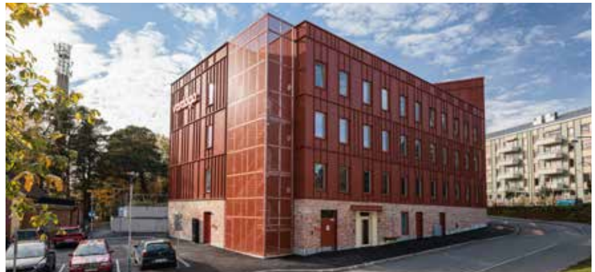
Färdigställd byggnation Telegrafan, Nynäshamn.
