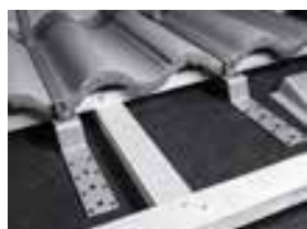
Alt 1. 25 mm läkt med träundertak: Träd ett nedåtvänt infästningsjörn på varje bygel.
