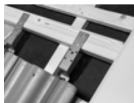
Alt 2. 45 mm läkt med lätt undertak: Montera en regel (45x95 mm) mellan två takstolar som infästnings punkt fästjärnen. Träd ett uppåtvänt fäste på varje bygel.
