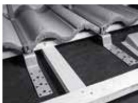
Alt 1. 25 mm läkt med träundertak: Träd ett nedåtvänt infästningsjárn på varje bygel.
