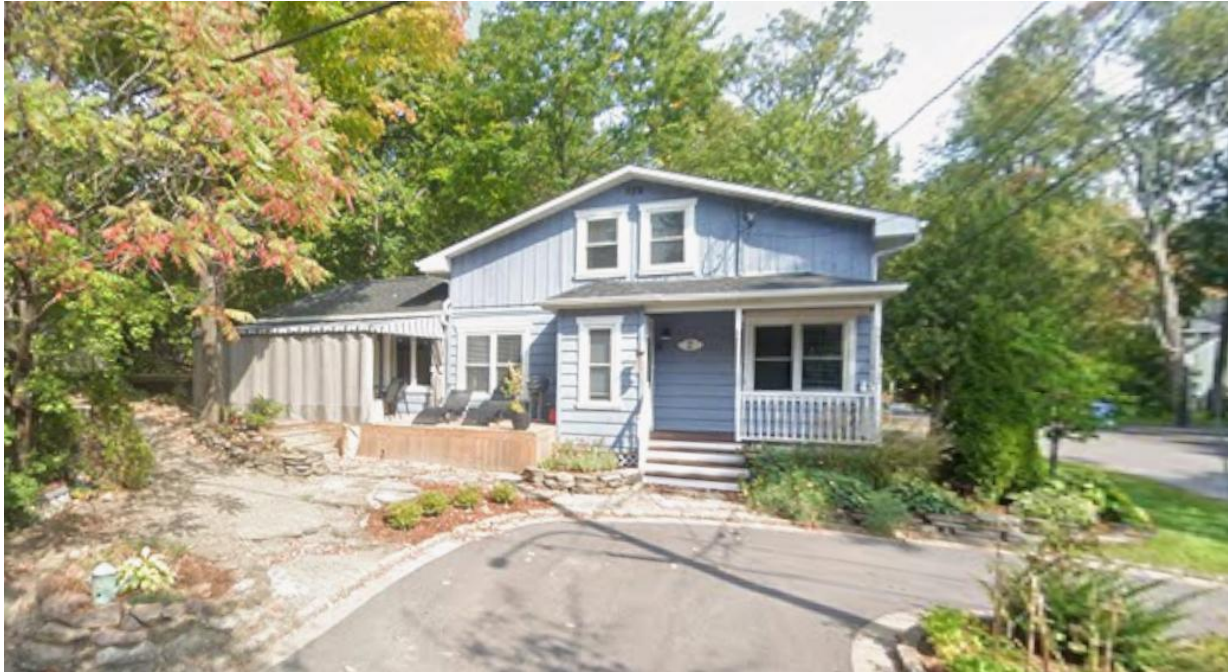
Figure 4 Habitation unifamiliale isolée de construction plus âgée sur la rue de l'Église
