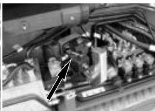
Fig. 64 Handbediende tuimelschakelaar handpomp
