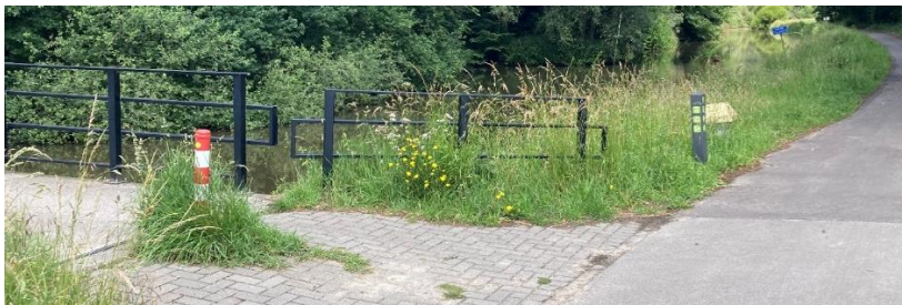
Knooppunt 43 met brug over rivier de Mark.
