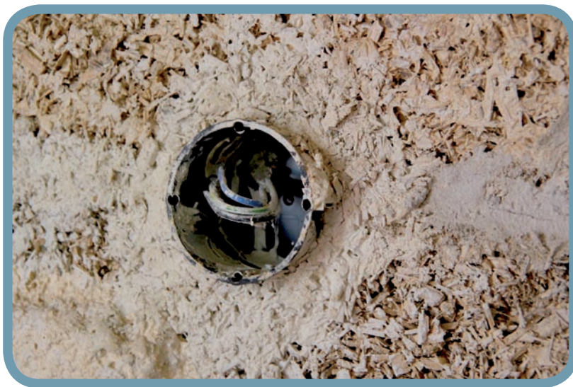
Nachträglich eingebaute Steckdose in einer Hanfkalk-Wand. Mit gängigen Werkzeugen zu schneiden und einfach zu reparieren, sodass Dosen, Leitungen oder Reparaturen punktuell und präzise ausgeführt werden können. © Dr. Norbert Höpfer
