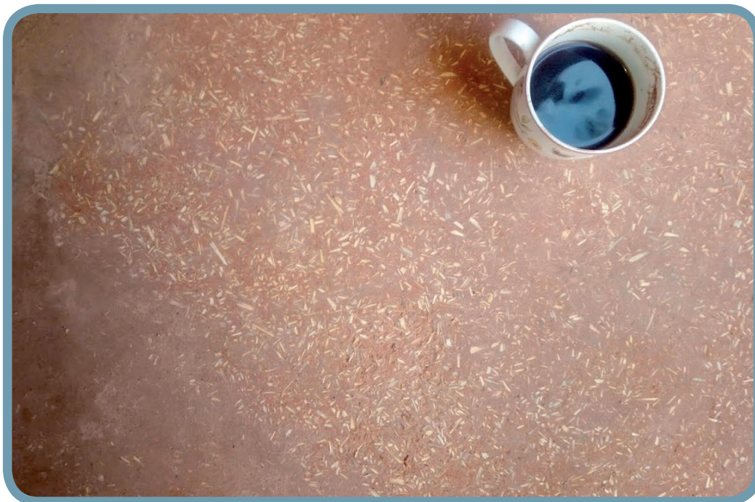
Deckschicht Fußboden: Pferdestallboden aus natürlich hydraulischem Kalk NHL, Tennissand und Hanfschäben, abgeschliffen, noch nicht geölt. © Dr. Norbert Höpfer
