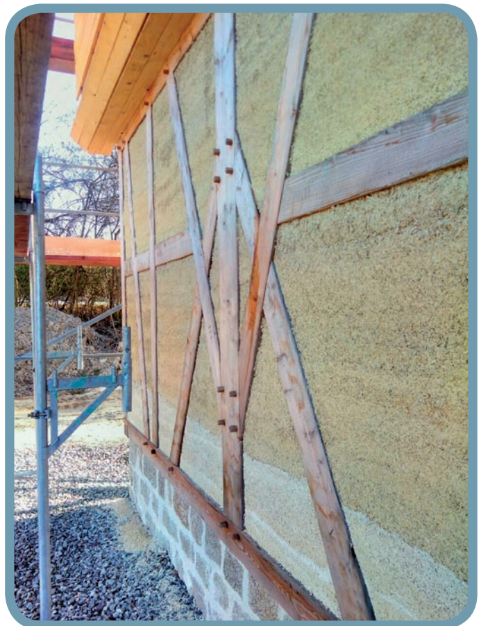
Orthanf als Ausfächung in einem traditionellen Fachwerk. Der Hanfkalk schützt das Holz-Ständerwerk besonders gut. © Dr. Norbert Höpfer
