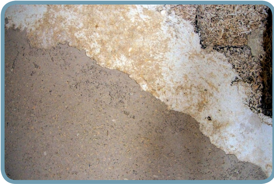
Zu sehen sind drei Schichten Hanfkalksteine als Innendämmung, darüber ein Hanfkalk-Grundputz und ein Hanfkalk-Feinputz. Der Feinputz wurde frisch aufgetragen und erscheint noch dunkel aufgrund der Restfeuchte. © Dr. Norbert Höpfer
