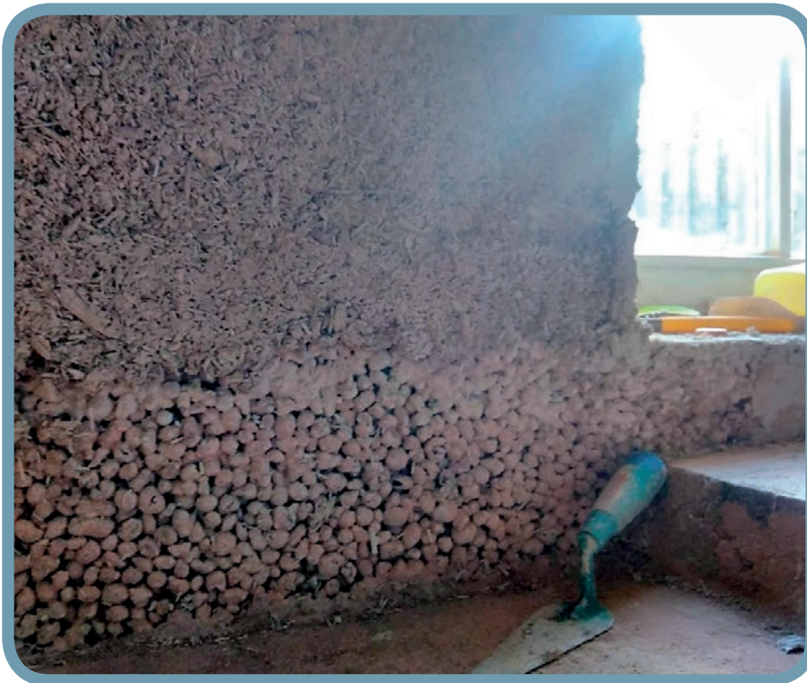
Hanfalk-Steine auf Kimmschicht aus Ziegeln, versetzt mit Kalkmörtel und Maurerschnur. © Dr. Norbert Höpfer
