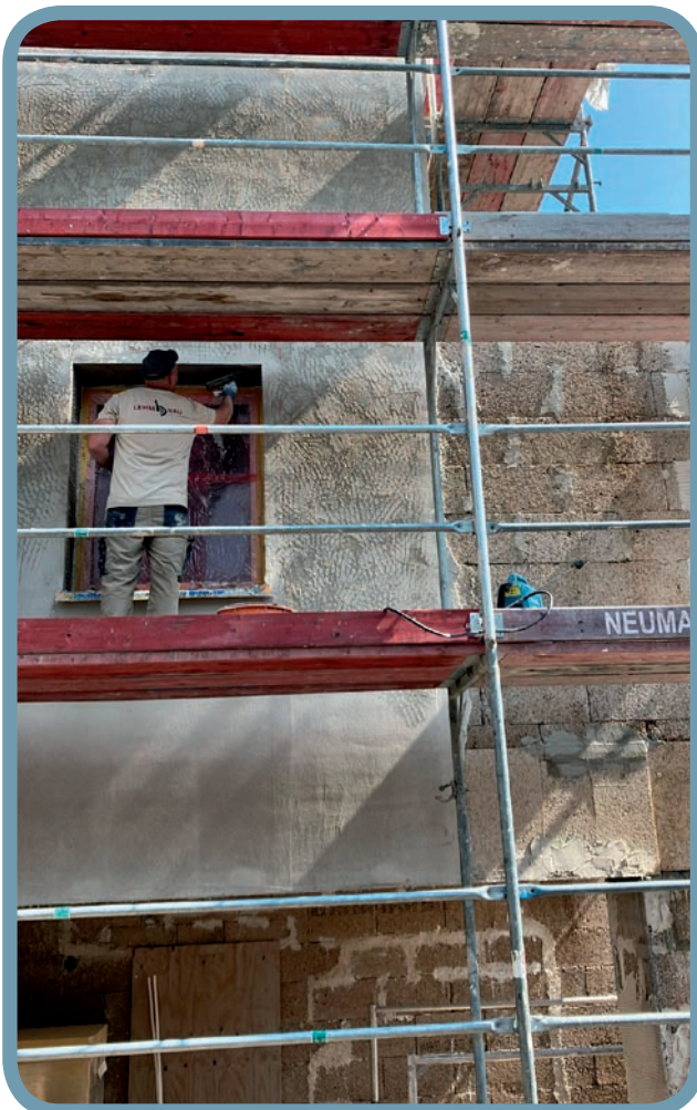
Zu sehen ist ein frisch aufgetragener Außenputz aus Kalk auf einer Hanfstein-Außenwand. © Dr. Norbert Höpfer
