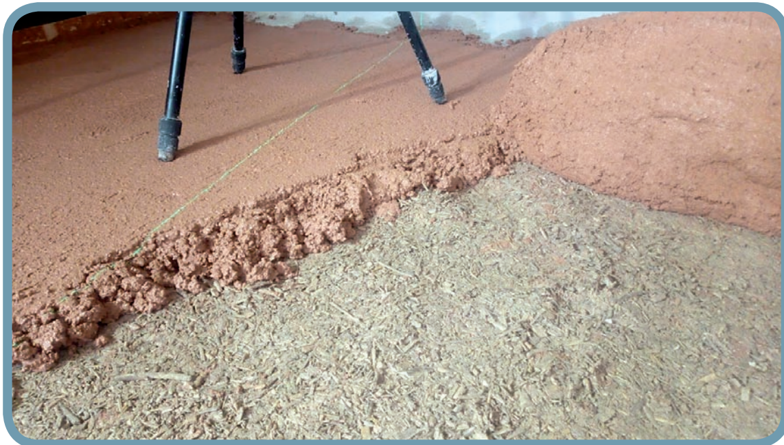
Frisch verlegter Hanfkalk-Estrich mit einer Deckschicht aus Kalk und Ziegelmehl, die sogenannte Pferdestallmischung. © Dr. Norbert Höpfer
