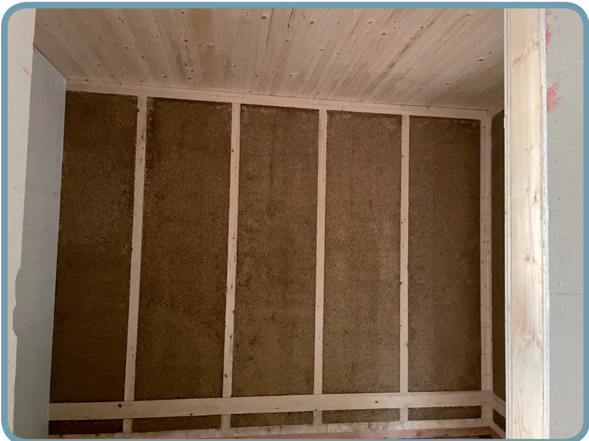
Diese Wandmodule wurden von der Firma Hanf & Kalk vorgefertigt und auf der Baustelle gefügt. © Matthias Maiwald
