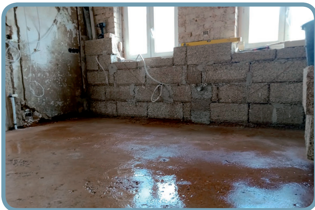
Frisch gelegter Hanfkalk-Estrich mit einer Deckschicht aus Kalk und Ziegelmehl (Pferdestallmischung). Im Hintergrund Hanfkalksteine als Vorsatzschale zur Innendämmung. © Dr. Norbert Höpfer
