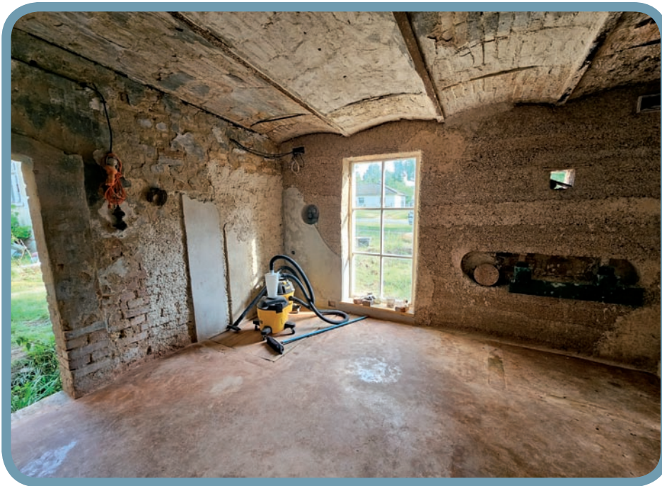
Verschiedene Anwendungen von Hanfbaustoffen in der Sanierung: links Bestandswand mit Hanfkalk-Dämmputz und verschiedenen Kalkoberputzen mit Hanfschäben als Zuschlag, vorne Orthanf als Innendämmung, unten Hanfkalk-Estrich mit Pferdestallmischung vor dem Polieren. © Felix Drewes, Klimapraxis
