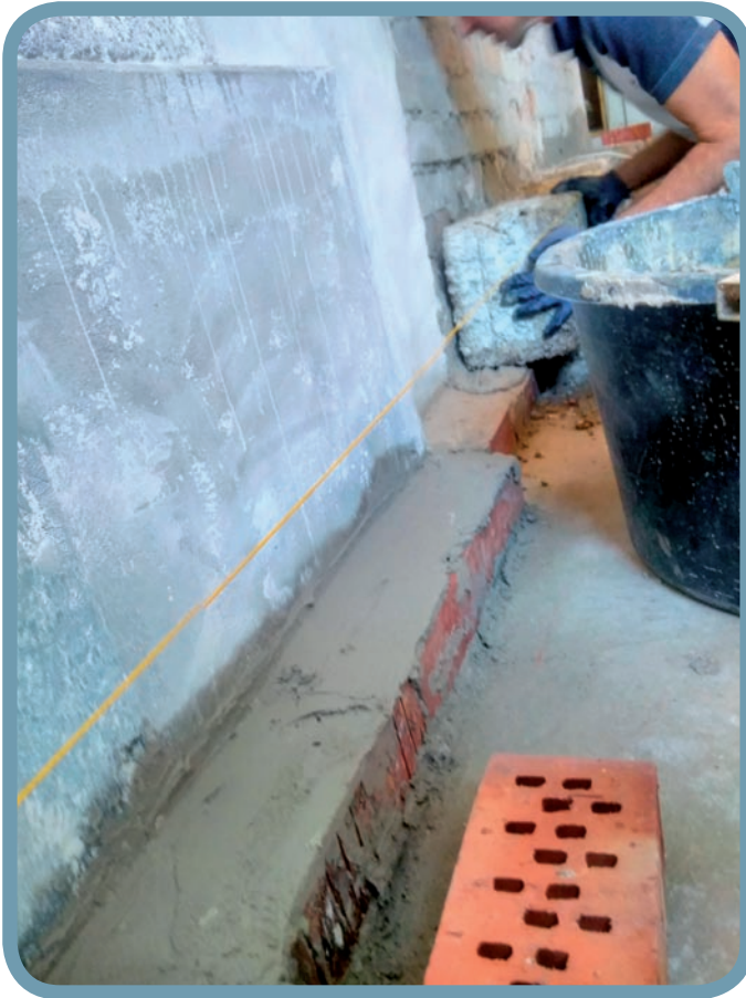
Hanfalk-Steine auf Kimmschicht aus Ziegeln, versetzt mit Kalkmörtel und Maurerschnur. © Dr. Norbert Höpfer
