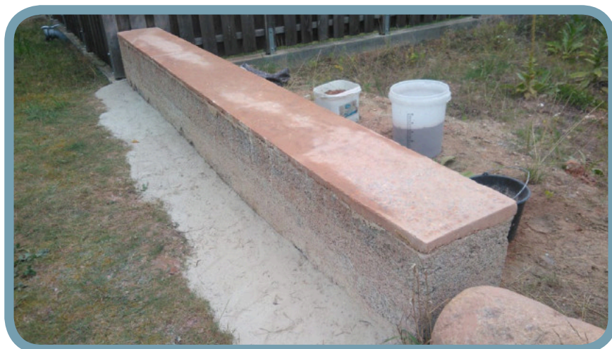
Fertige Sitzbank aus Hanfkalk. Oben drauf der „Estrich“. © Klimapraxis
