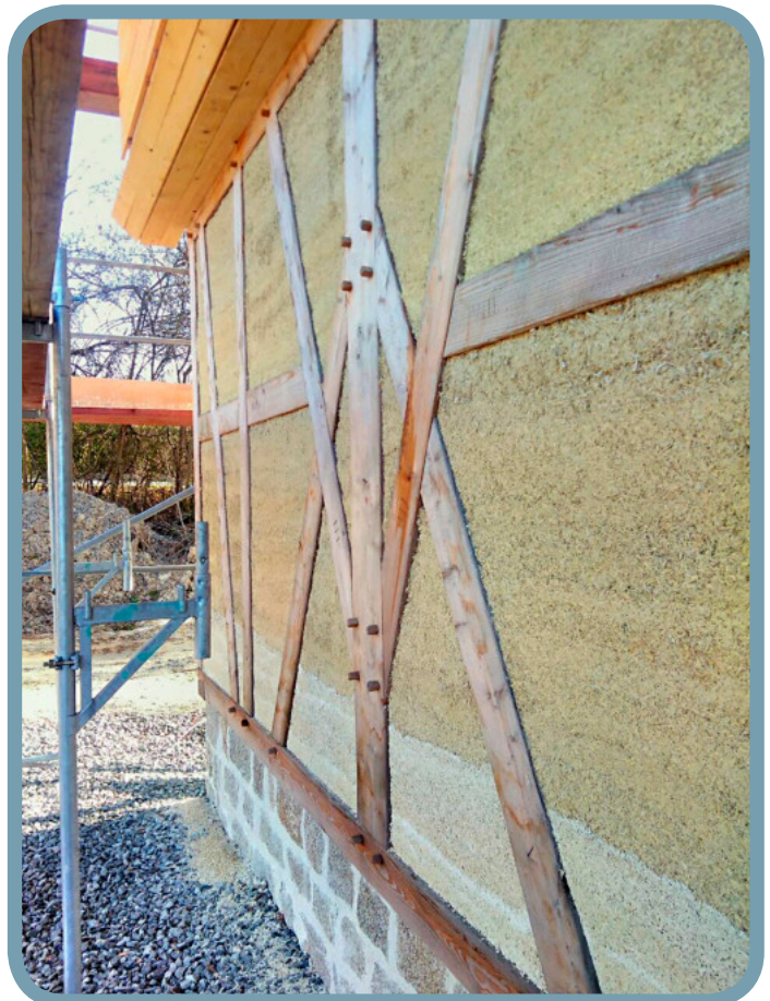
Orthanfalk als Ausfüllung im Fachwerk – Schäben aus Zempow. © Norbert Höpfer
