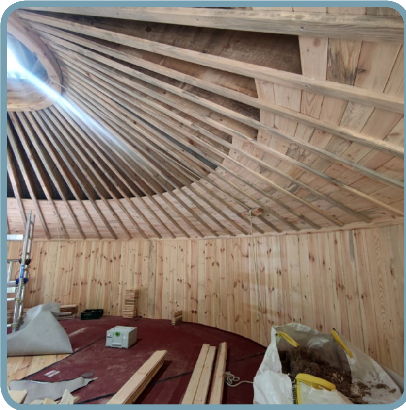
Jurte mit Hanffaser-Dämmung. © Klimapraxis
