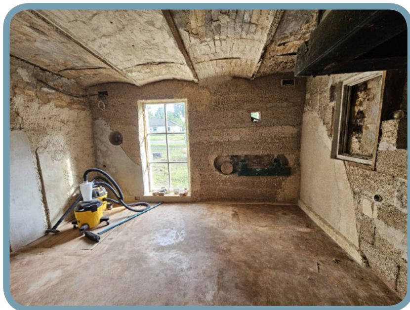
Showroom Zempow mit verschiedenen Hanfbautechniken aus Materialien vom Hof (von links nach rechts: dämmender Putz mit Schäben, Orthanf, Hanfkalk-Steine mit Kalkputz; am Boden Hanfkalk-Estrich nach Pferdestallmischung). © Felix Drewes, Klimapraxis
