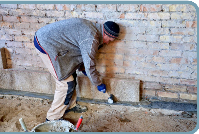
Hanfalk-Steine aus der Manufaktur werden verbaut. © Klimapraxis
