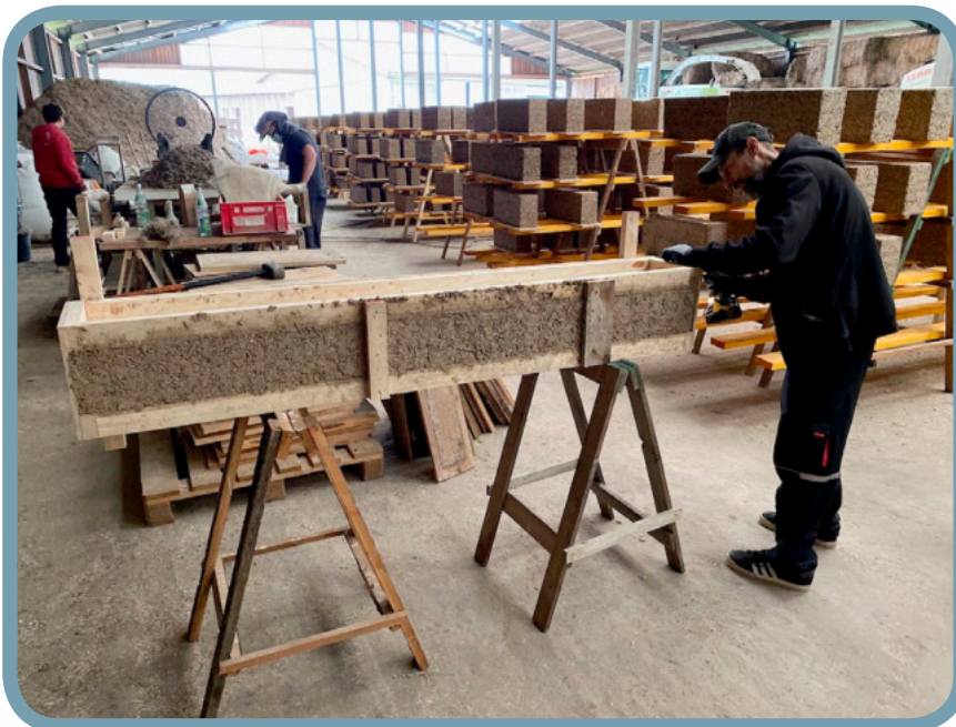
Holzschalung für eine Sturzform. Beispiel für ein Sonderformat. © Bio Ranch Zempow
