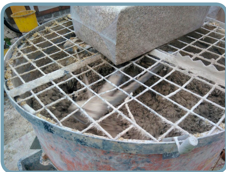
Mischvorgang der Hanfkalk-Rezeptur im Zwangsmischer auf der Bio Ranch Zempow. © Klimapraxis / Bio Ranch Zempow
