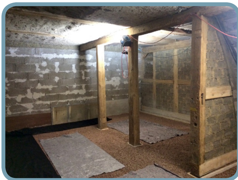
Sohldämmung mit loser Hanfschüttung in der Pop-up-Manufaktur Breddin. © Mira Dih / Klimapraxis
