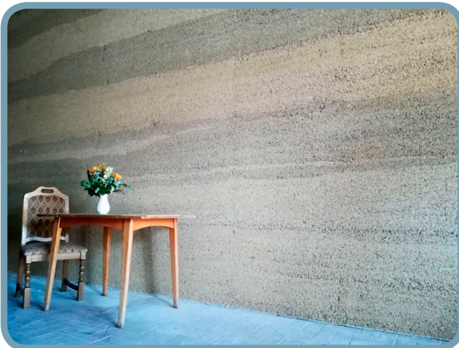
Innenwand aus Hanfkalk mit Farbverlauf-Gestaltung. © Jolande Olschewsky
