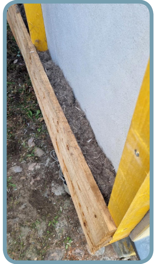
Sockel-Detail Hanfwolle Außendämmung. © Bio Ranch Zempow / Klimapraxis
