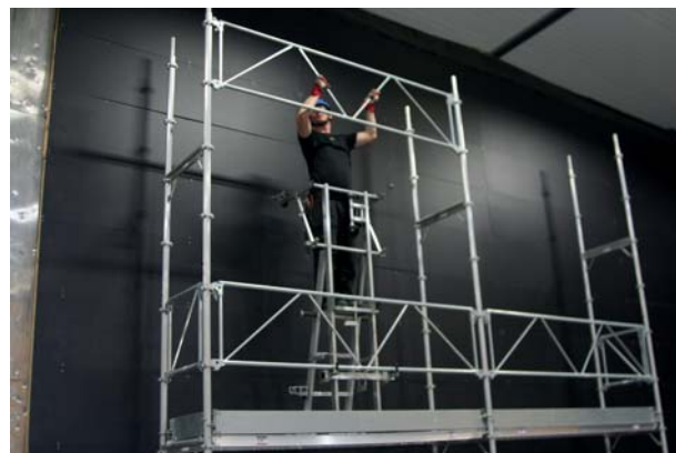
+8 HiMount med H-ramme på aluminiumstillas
