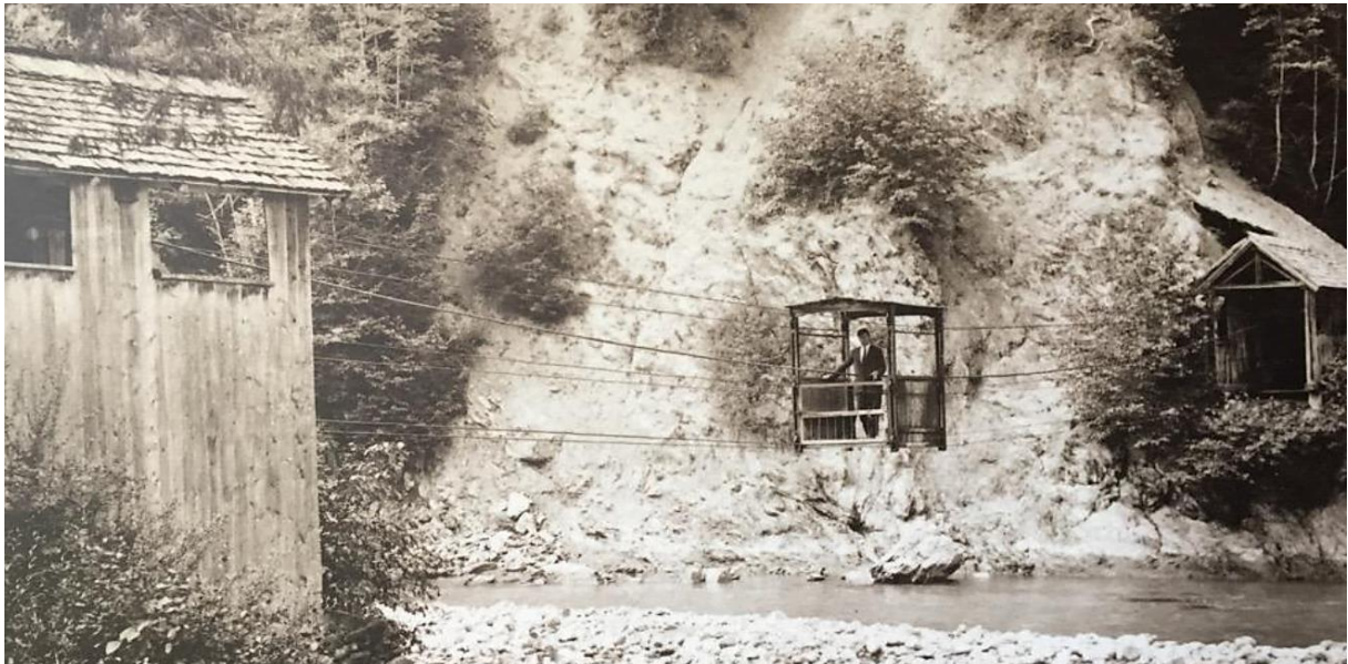
Die Wirth Fähr mit den sechs Tragseilen, den 12 Rollen und dem Zugseil in der Mitte. Bei der Fährstation auf Schwarzenberger Seite wurde das Dach bis an den Berghang gezogen damit die herabfallenden Steine die Station nicht beschädigen können
