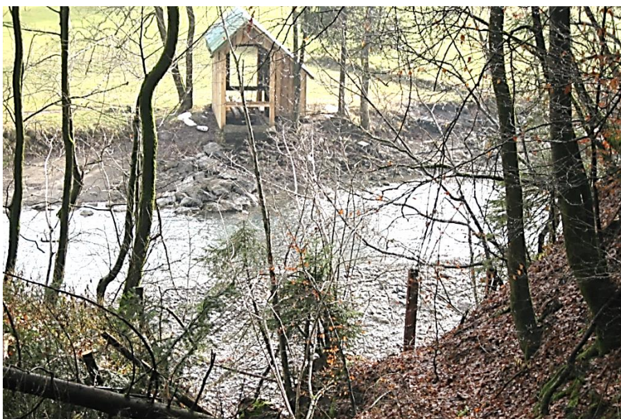
Die Fährre 2008 mit den Überresten auf Schwarzenberger Seite. Zwei Eisensteher bleiben als Relikt der Fährstation Schwarzenberg noch übrig. Der Zugang zur Fährstation ist noch ansatzweise vorhanden. Der Bach in der Mitte des Bildes vollendete die totale Zerstörung der Anlage.
