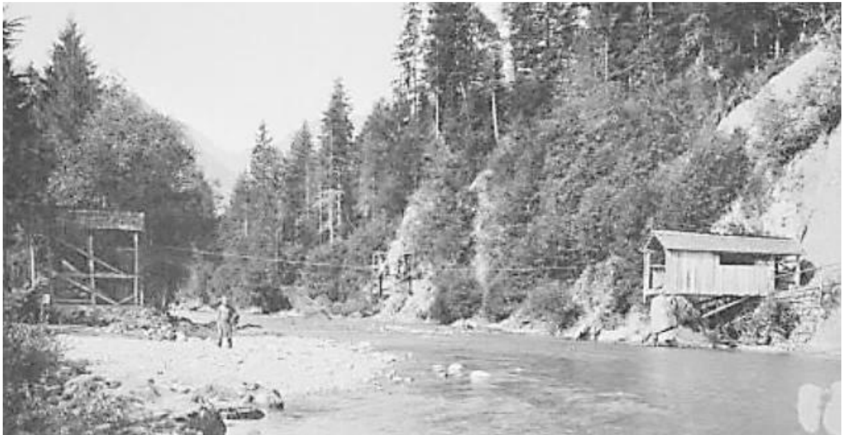
Fährre Wirth „zur Ach“ vor 1910, rechts die Schwarzenberger Station mit dem riesigen Felsblock, auf dem der Unterstand befestigt war. Dieser wurde beim Hochwasser 1910 unterspült und weggerissen
