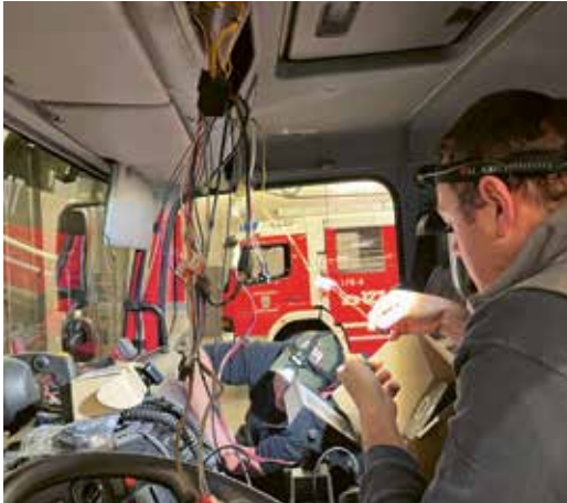
Mattias Braun und Andreas Ritlop beim Einbau des Fahrzeugfunkgerätes.
