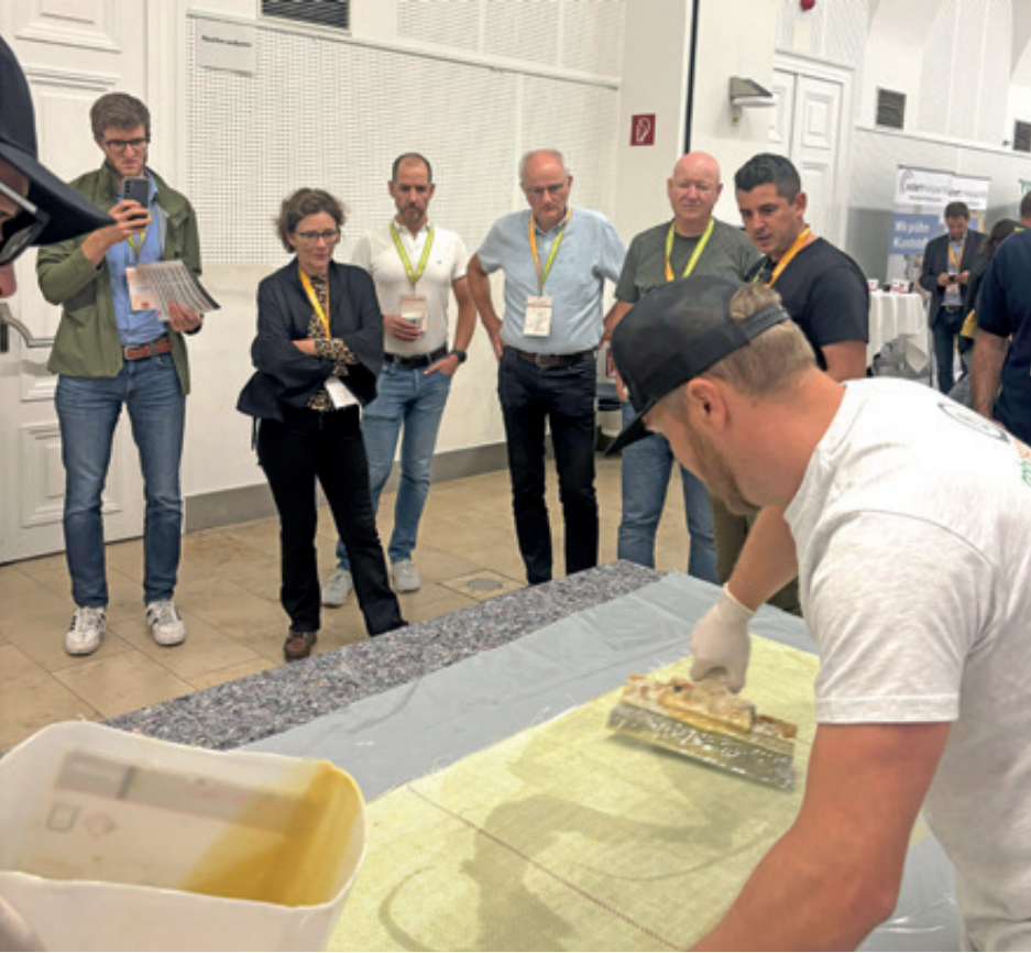
Eine Schachtsanierung in Echtzeit wurde am zweiten Veranstaltungstag demonstriert.
