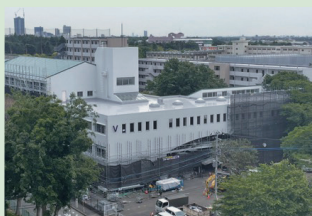
相模原キャンパスV棟(工事中)の様子。外見は完成に近づいています。
