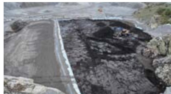
Jonny Ellertsen sørger for at massen planeres med riktig fall og tettes med duk og rene masser.
