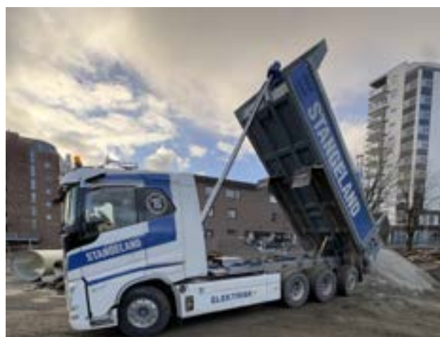
En av våre ni elektriske lastebiler holder byggeplassen i gang – utslippsfritt og imponerende stillegående.
