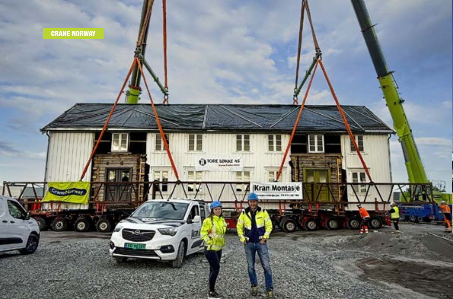
Thea Stridshol og Anders Bjørgen i Crane Norway er på plass når det tyngste verneverdige huset på 80 tonn skal løftes over på spesialtransport og kjøres til Vipetangen.
