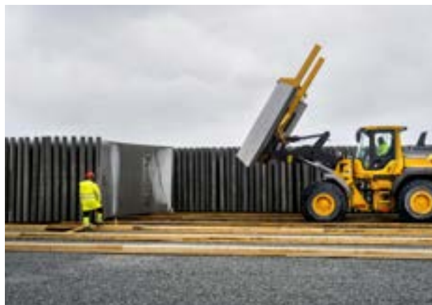
Betongelementene som kommer med lastebåten Peak Sauda blir lagret på Krågøy.
