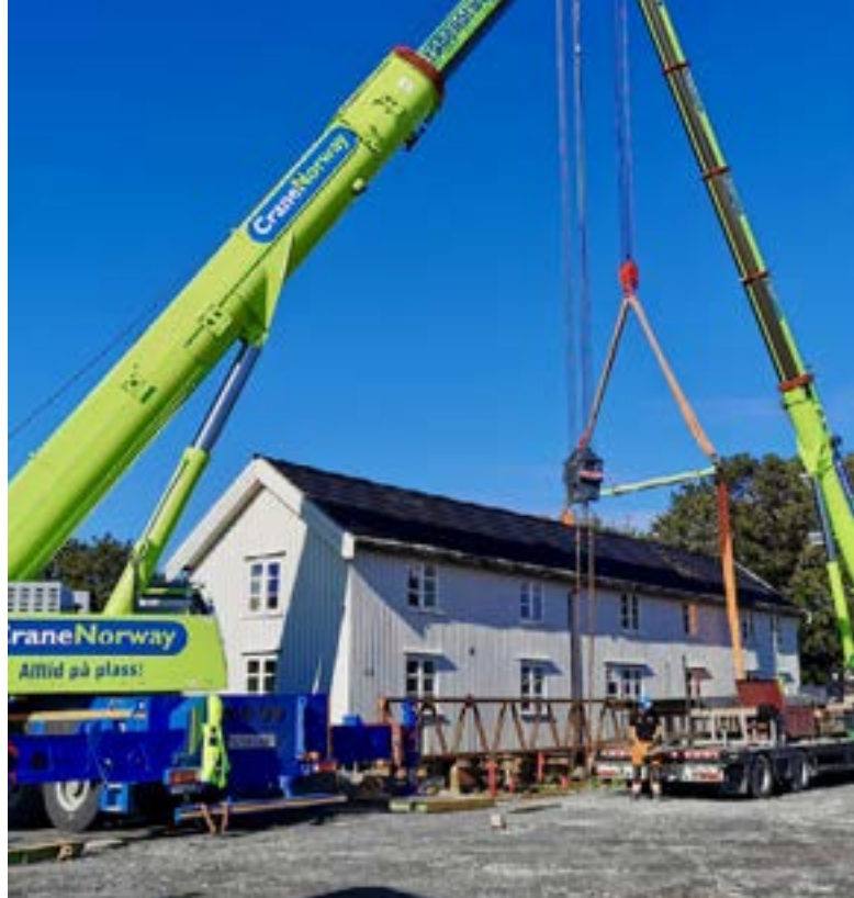
Det er til sammen 26 vernede hus som skal flyttes fra Ørlandet til Vipetangen. Alder og tilstand på de gamle husene er den største utfordringen i løfteoperasjonene. Foto: Trøndelag fylkeskommune
