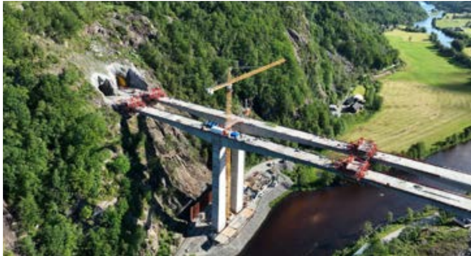
Her fra arbeidet med sammenkoblingen av Kvelland bru på E39 Lyngdal. Foto: Rita Tvede Bartolomei
