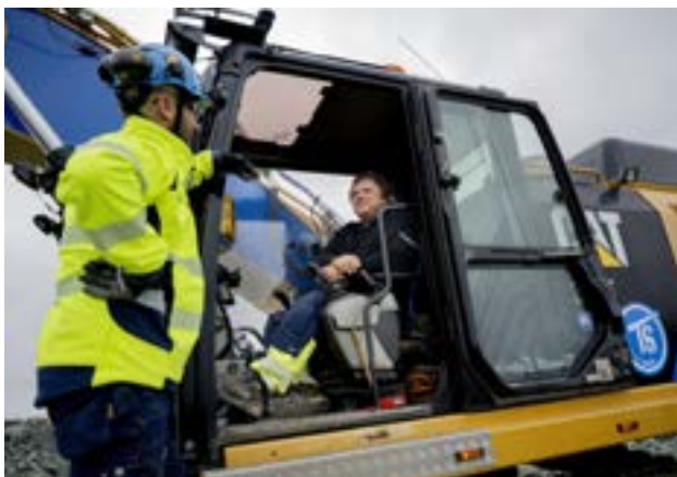
Prosjektleder John Olaf Østerhus i samtale med maskinfører Johannes Eide.
