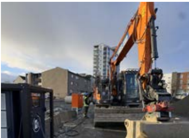
Elektriske gravemaskiner gjør tunge oppgaver – uten å legge igjen klimagassavtrykk.
