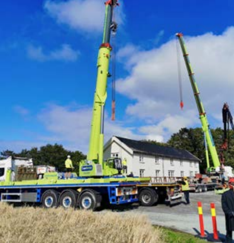
To 250 tonnns mobilmaster brukes til å løfte husene over på spesialtransporten. Så kjører lastebil og mobilkraner til Vipetangen for løft over på ny grunnmur. Foto: Trøndelag fylkeskommune
