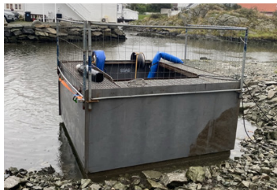
Hevet utløpskum og pumpeløsning hindrer innsig av sjøvann – og holder fremdriften oppe i Rådhusvegen.
