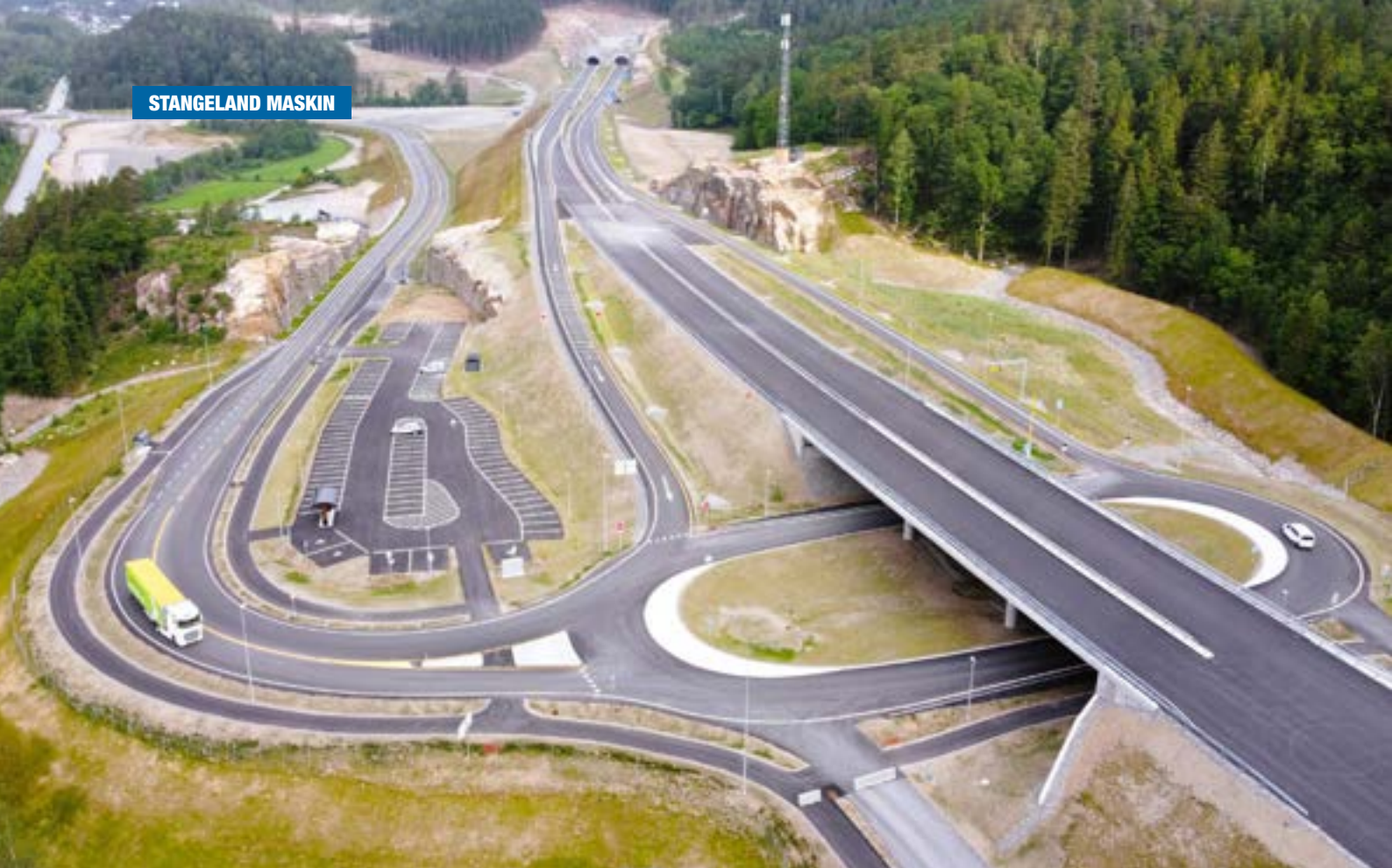
Herdalkrysset lengst vest i prosjektet. Påkjøringsrampe, park and ride, kollektivlommer, sykkelparkering, rundkjøring og bruer. Foto: Nils Bernt Rinde/Nye Veier
