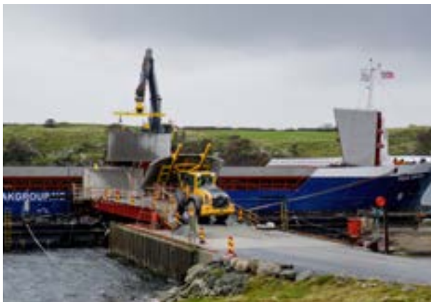
To laster med til sammen 900 elementer er allerede losset via den 62 meter lange spesialkaia som er bygget for formålet.
