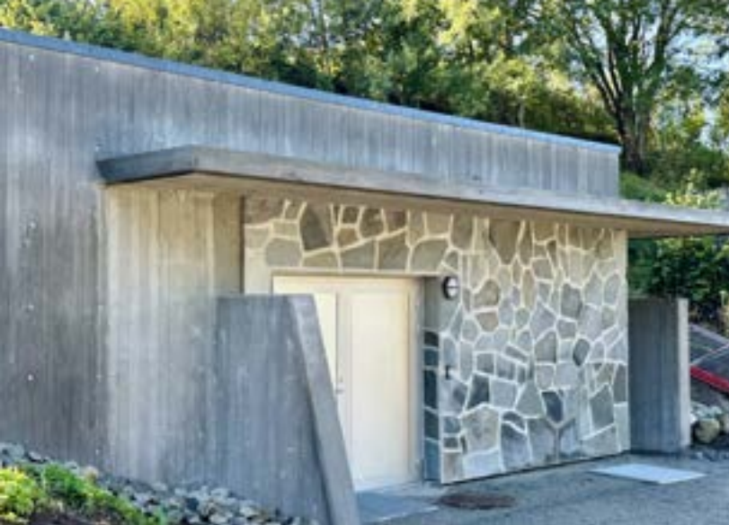
Den nye pumpestasjonen gir en tryggere og mer effektiv håndtering av avløpsvann i Sola kommune.
