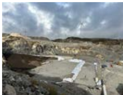
Filterkaker fra saneringen av Slettebakken deponeres i en spesialtilpasset avfallscelle ved Svaatheia Avfall.
