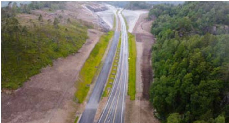
Fremtidens planfrie kryss på Røyskåre er ferdig utsprengt lengst vest i prosjektet. Legg merke til steinterskelene, som skal hindre erosjon fra overflatevann. Foto: Nils Bernt Rinde/Nye Veier
