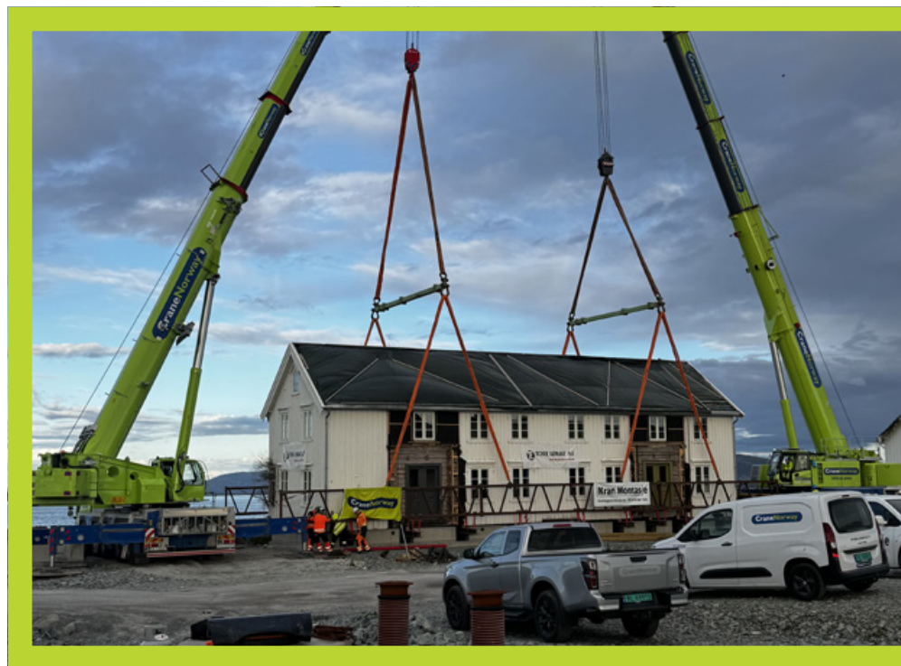
Etter 4,3 kilometer langs veien løftes huset på plass på ny grunnmur på Vipetangen. Foto: Thea Stridshol.
