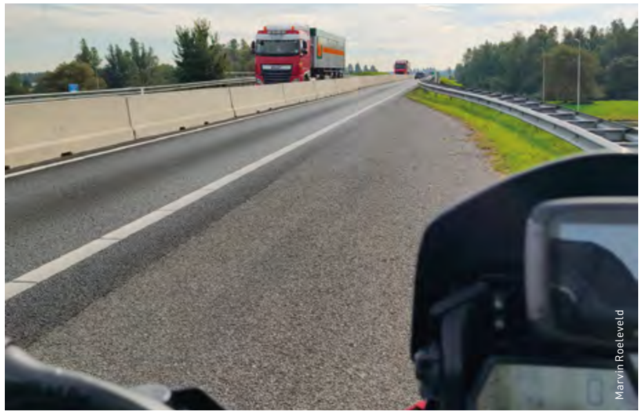
De N50: beton links, vangrail of steil talud rechts....
