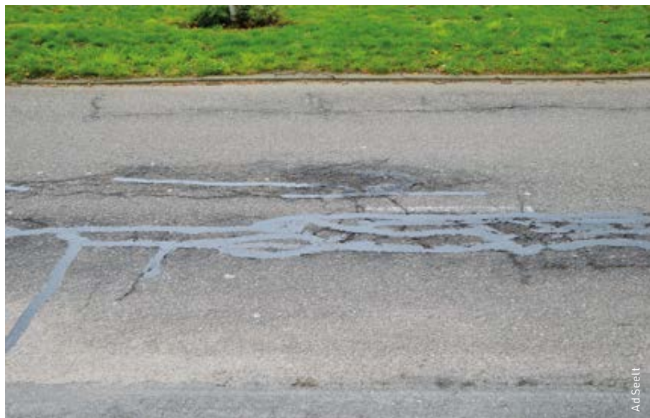
Eerste reparatiefase Banneweg, Gorinchem
