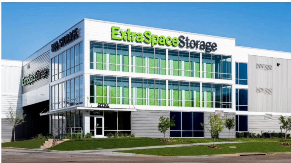
Propriedade de self-storage do Extra Space Storage. Fonte: IR Extra Space Storage.
