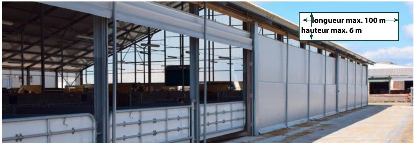
**Technique de paroi à enroulement ; ouvert et relevé à gauche ; fermé à droite**
