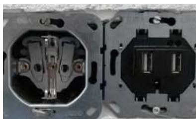
Voorbeeld verwijderde kapjes van stopcontacten en schakelaars, klaar voor stucwerk.
