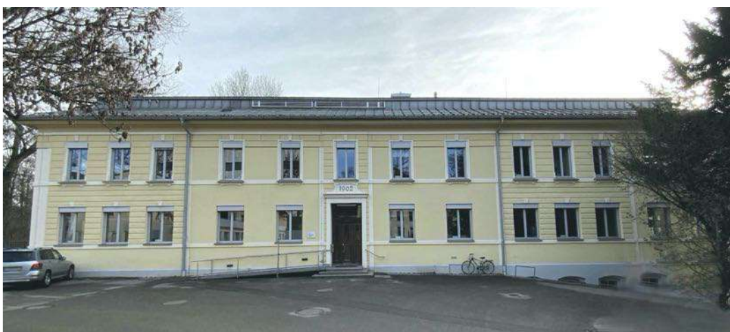
Abb. 4.04 Institut für kleine Haustiere (1902) nach Sanierung 2014
