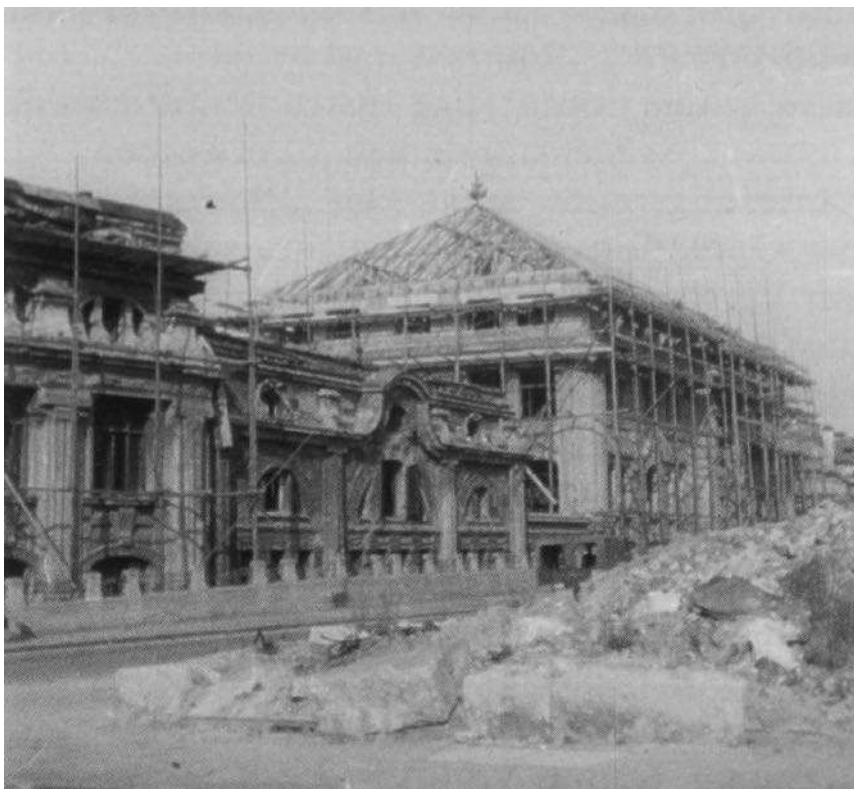
Abb. 2.17 Richtfest des Klinik- Mittelbaus nach Erneuerung des Daches; die Fassaden sind bereits „bereinigt“ 24.09.19448 (Driesch 1990, Abb. 11)
