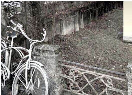
Abb. 4.27 Detail der historischen Mauer
