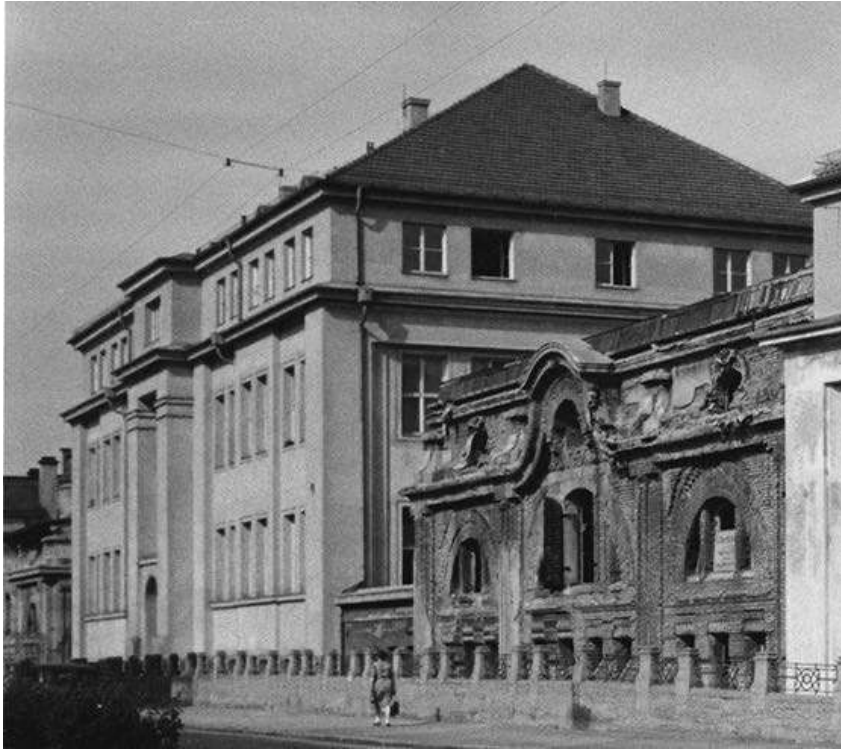
Abb. 2.18 Klinik-Mittelbau nach Fassadenbereinigung , am Rand erkennbar Externe Klinik ebenfalls fertiggestellt Foto 8.07.1952 (Stadtarchiv Mü, Fotosammlung, FS- STB-4686)
