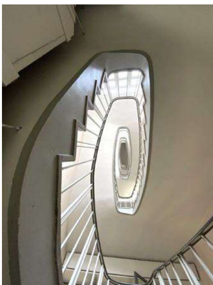
Abb. 4.15 Treppenhaus in ovaler Form mit filigranen Stäben
