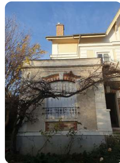
Façade Est extension
