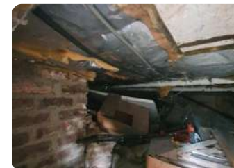
Plancher sur vide sanitaire
