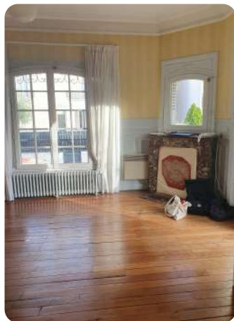
Fenêtre PVC double vitrage (à gauche) et fenêtre bois double vitrage (à droite)
