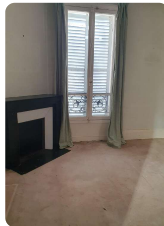
Fenêtre bois simple vitrage
