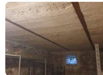
Plancher sur sous-sol
