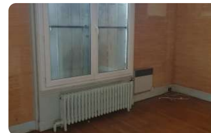
Radiateur à eau et convecteur électrique
