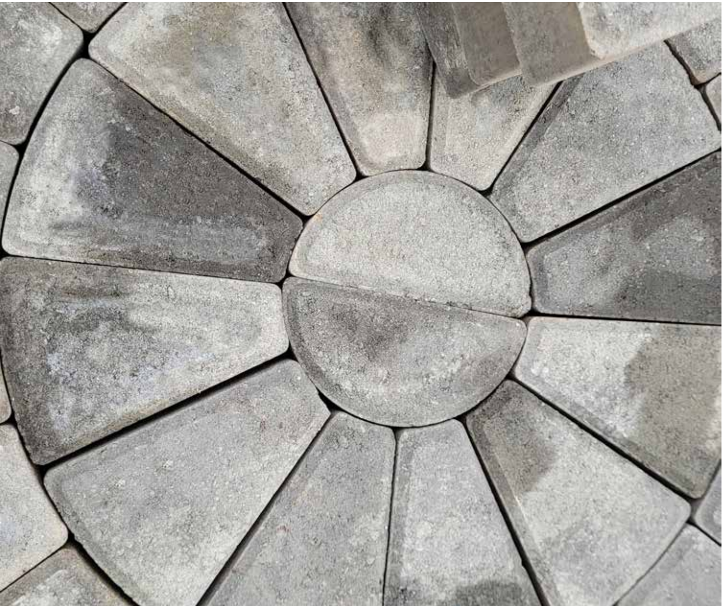
Se bilde over: Steiner skal legges med ca 2 mm åpning mellom hver stein. Bildet viser detaljer fra Aas Baron sirkelstein.
