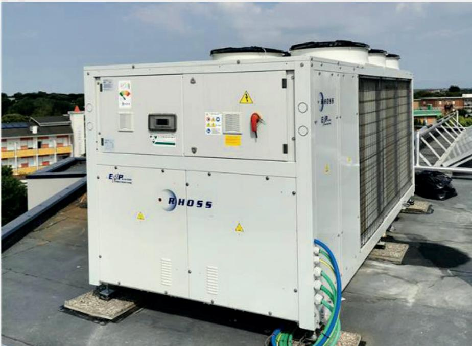
Para ofrecer una respuesta clara a los sistemas de producción de climatización basados en R290, esta gama permite atender instalaciones a 4 tubos, maximizando la eficiencia operativa de todo el sistema. Permite la producción de agua a alta temperatura para climatización y puede ser utilizada en la estación de refrigeración para garantizar una producción gratuita de ACS a alta temperatura.
