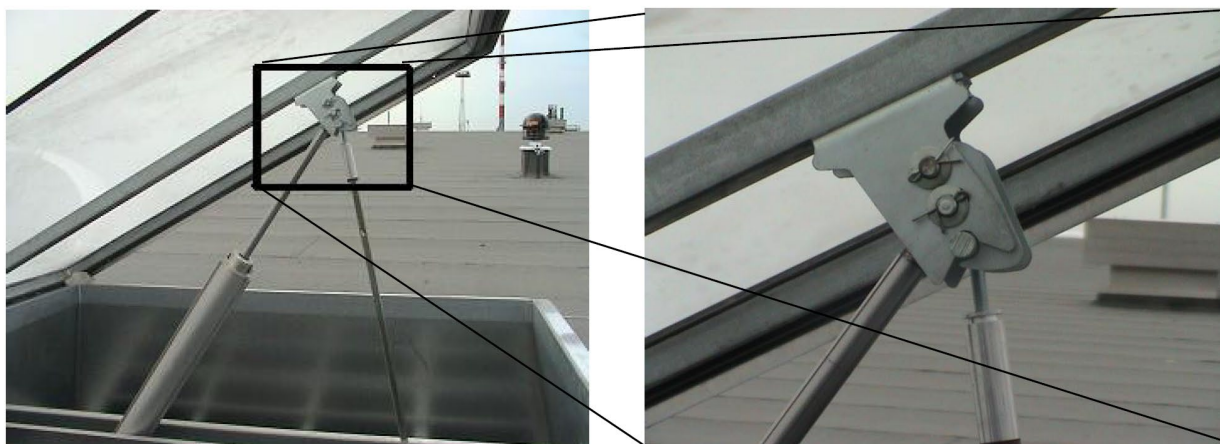
Fig. 22 Junção entre o atuador e a consola de gancho
