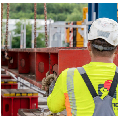
Vorbereitung der Transporte
