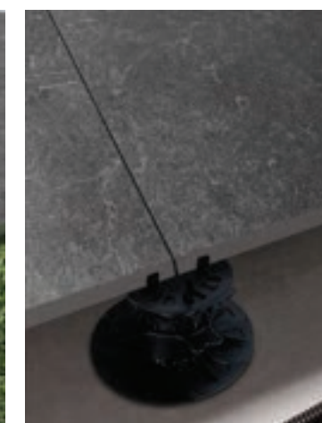
Pose sur supports
